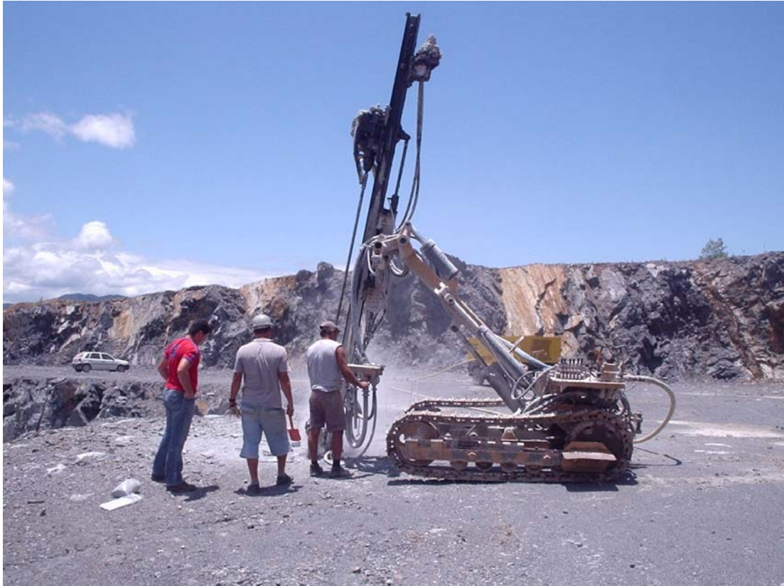
Figura 03 – Perfuração com equipamento “rock drill” respeitando inclinação do corpo.
